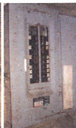
Panneau de type 1 dans une atmosphère corrosive
