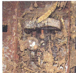
Coupe-circuit manuel de type 1 poussiéreux
