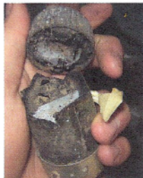
Fusible 100A grillé
